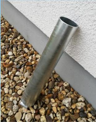
Zur stabilen Verankerung des Mastes benötigt man eine Bodenhülse, die in ein Betonfundament eingelassen wird. Wegen der Frostsicherheit und der entstehenden Hebellast sollte das Loch immer mindesten 80 cm tief sein. Eine Drainage aus Kieselsteinen gewährleistet den Wasserablauf ins Erdreich.
